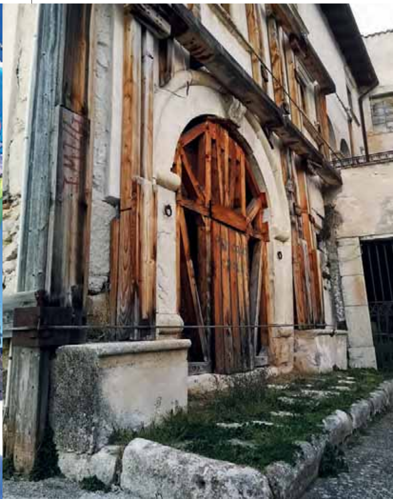
• Uno dei tanti borghi flagellati dal terremoto
